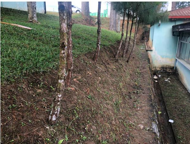
Figura 29b) Talud de relleno con protección. Nivel de suelo de relleno, evidenciando proceso de reptación en arboles de pino, modulo G.
