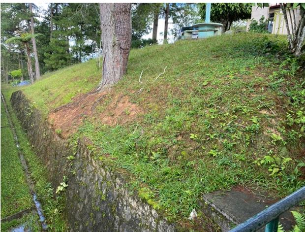
Figura 29c). Desplazamiento de suelo arcilloso, dentro de talud de relleno con protección. Modulo G.
