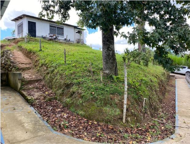
**Figura 24.** Vista de superficie de relleno y corte donde se observa sobrepuesto material de relleno y horizonte orgánico (H) perteneciente a la superficie natural soterrada.
