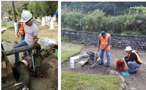
**Figura 2.** Fotos que muestran la medición de niveles de agua subterránea.
