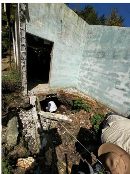
**Figura 8.** Colapso por karst y daño a infraestructura dentro del sitio del Centro Convergencia.
